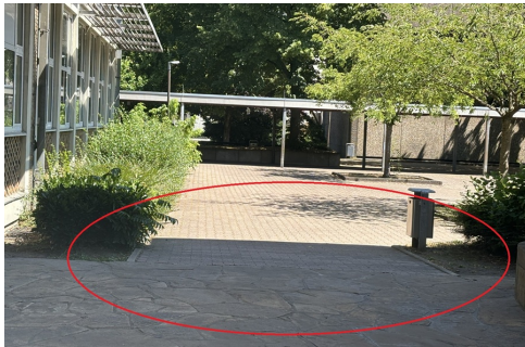
Abb. 2.13: Rampe im Hofübergang, [11, ful]
