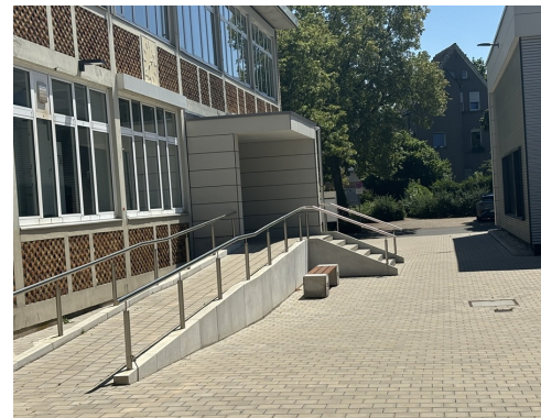
Abb. 2.14: Rampe ins Werkstattgebäude, [11, ful]
